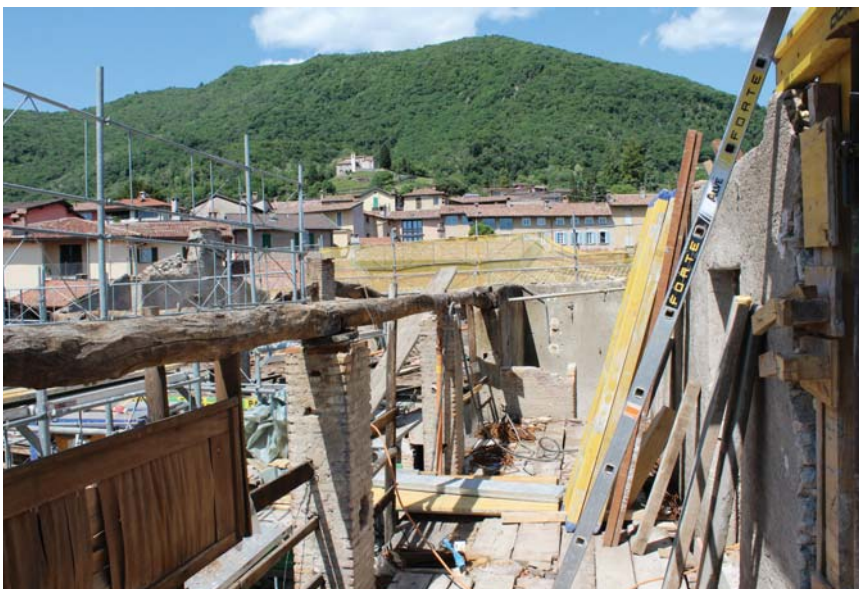
Smantellamento del tetto originale con il mantenimento dei pilastri originali dei ballatoi in mattoni.
