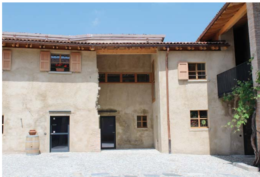
La situazione come si presenta oggi con la porta di accesso all'enoteca sulla sinistra e, al primo piano, le finestre dell'appartamento di 3.5 locali. Sulla destra, in basso e al centro, i locali del preasilo.
