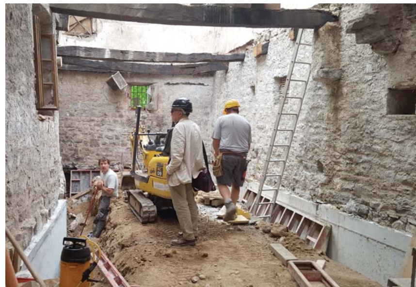
Sottomurazioni del locale oggi adibito a deposito per la sala polivalente.
