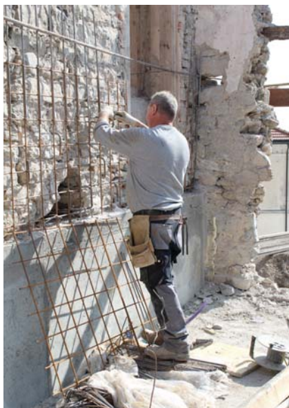
Armatura e consolidamento di uno dei muri perimetrali.
