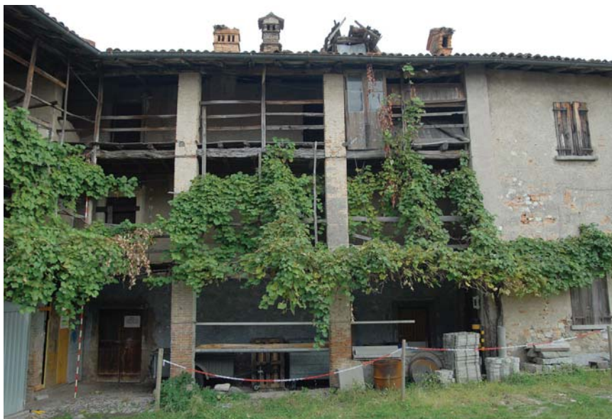
Foto dei ballatoi, lato Municipio, poco prima dei lavori di ristrutturazione.
