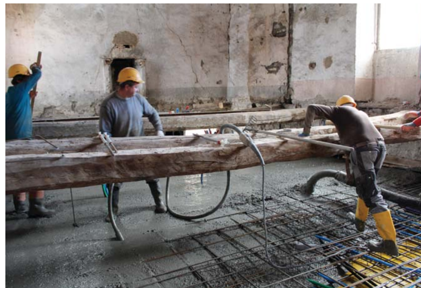
Fase di esecuzione della soletta degli appartamenti al primo piano.
