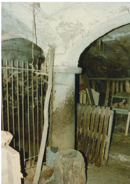
La colonna centrale delle quattro volte di una stalla.
