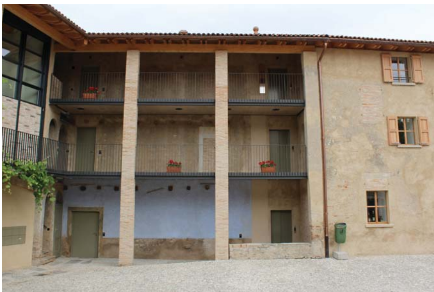
La situazione attuale dopo i lavori.
