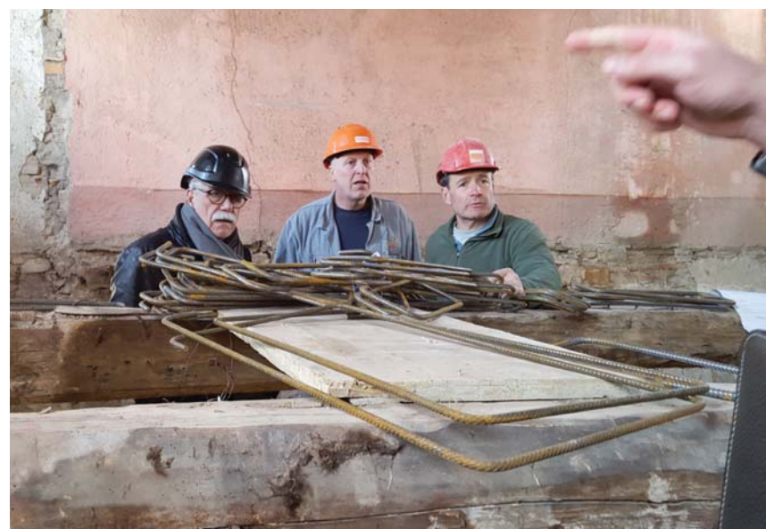
Discussione di cantiere con l'Arch. Quaglia (sulla sinistra) e i responsabili dell'impresa di costruzione.
