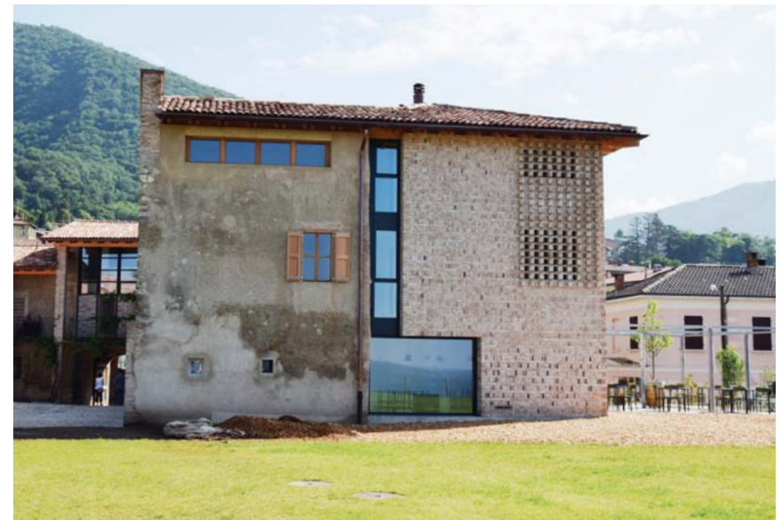
Lato sud dopo la ristrutturazione con l'area verde in primo piano.
