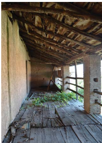
Il ballatoio al secondo piano prima e dopo la ristrutturazione.
