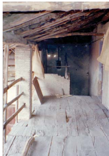
Il ballatoio al secondo piano prima e dopo la ristrutturazione. Accesso alle scale.
