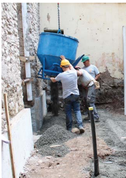
Altre due fasi di sottomurazione dei muri perimetrali.
