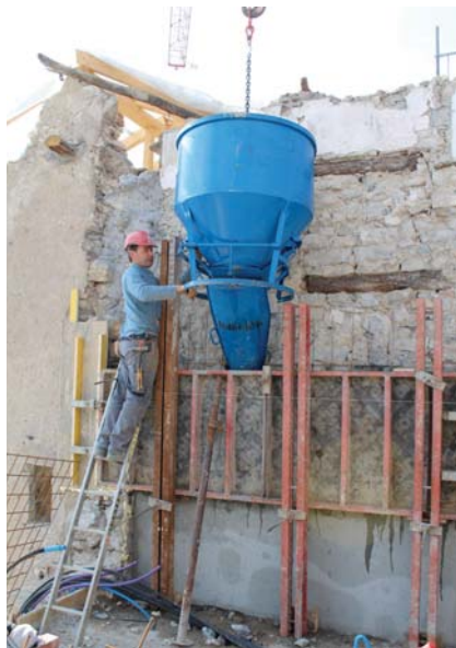
Intervento di consolidamento di uno dei muri perimetrali.
