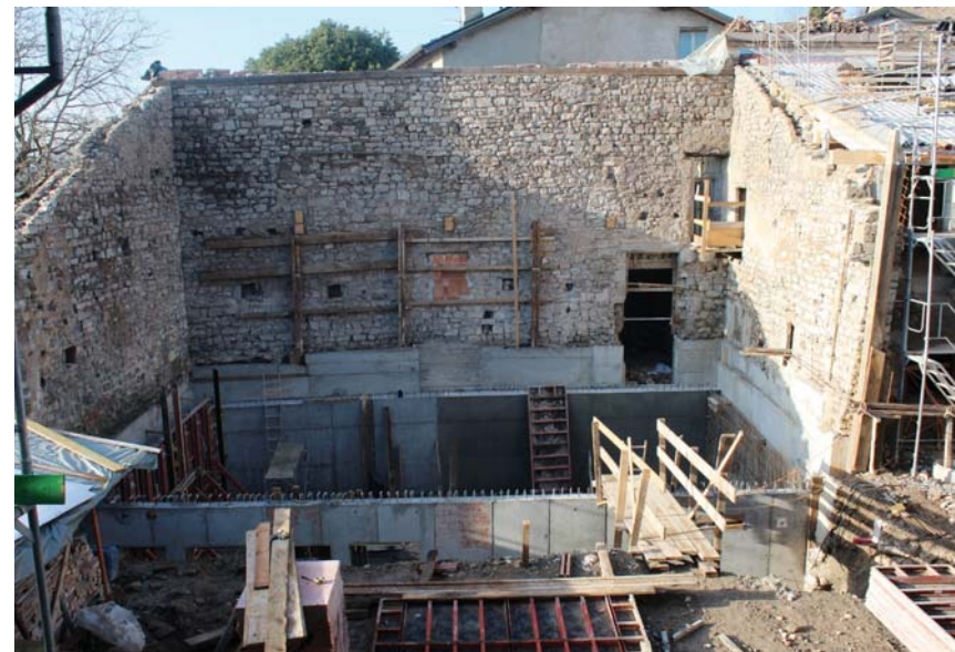
Costruzione del piano interrato adibito a locale tecnico e ad archivio comunale, sottostante la sala polivalente e le due sale riunioni.
