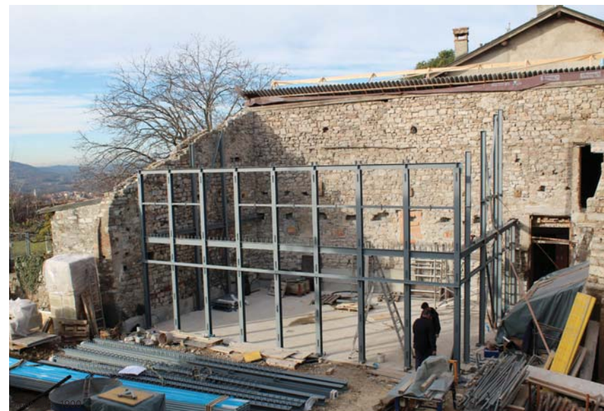
La struttura metallica portante della sala polivalente (al pian terreno) e delle due salette riunioni al primo piano.
