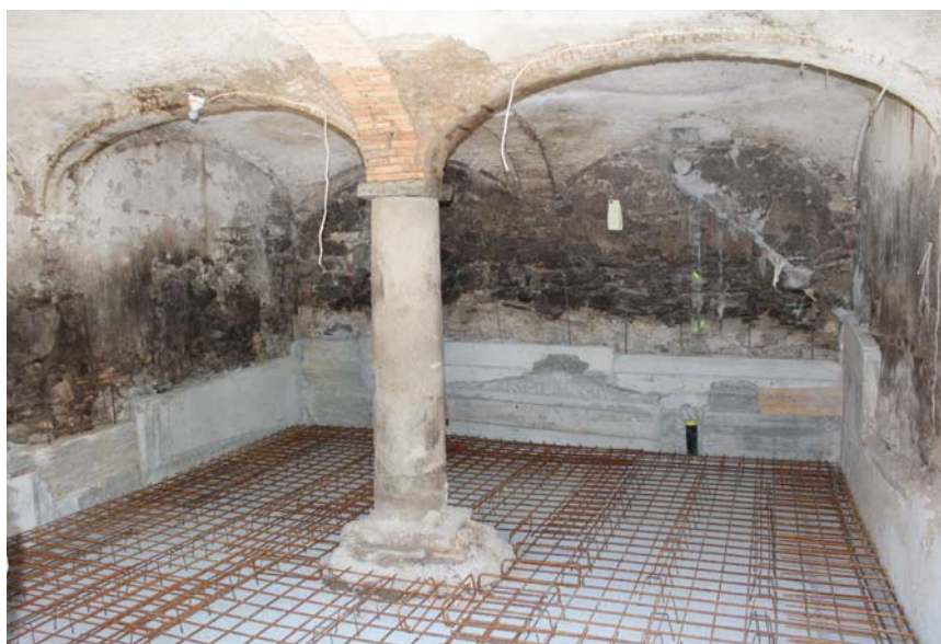
La colonna centrale di una delle ex stalle durante le fasi di costruzione del pavimento.
