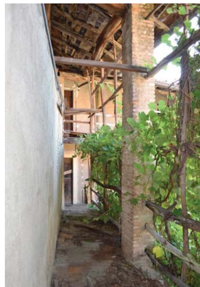
A sinistra il ballatoio sopra il portone di ingresso prima dei lavori e, a destra, la situazione attuale.
