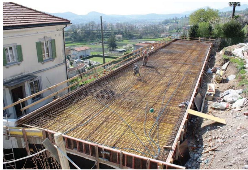
Esecuzione della soletta di copertura dell'autorimessa (posteggi degli appartamenti).
