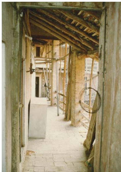
Vista sul ballatoio sopra il portone di ingresso.
