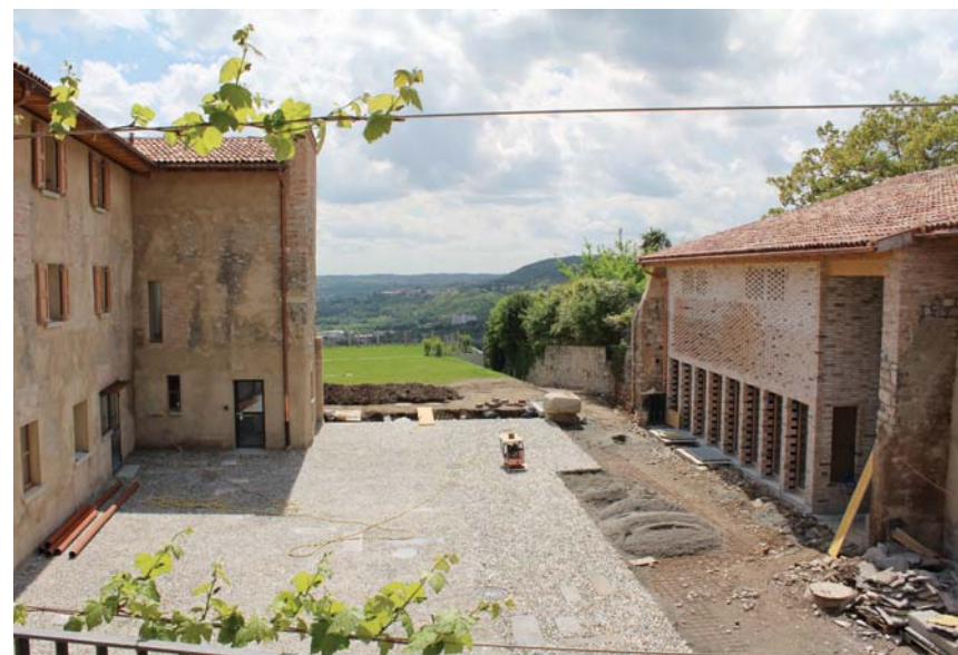
Vista dal ballatoio sulla corte in fase di pavimentazione.
