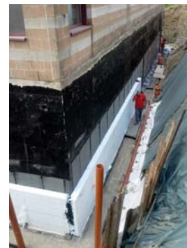
I lavori di risanamento dei muri laterali della palestra per evitare le infiltrazioni di acqua.
