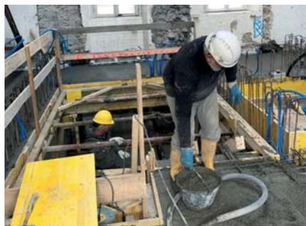
A sinistra l'esecuzione delle pareti del corpo dell'ascensore al piano seminterrato. A destra durante il getto della soletta del pian terreno.
