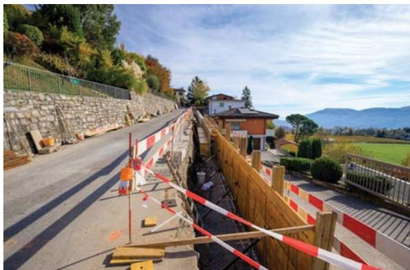
Le fasi di costruzione del muro di sostegno del marciapiede.
