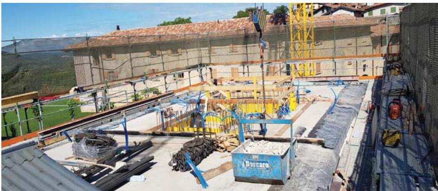
Soletta del secondo piano con al centro il vano dell'ascensore e delle scale.
