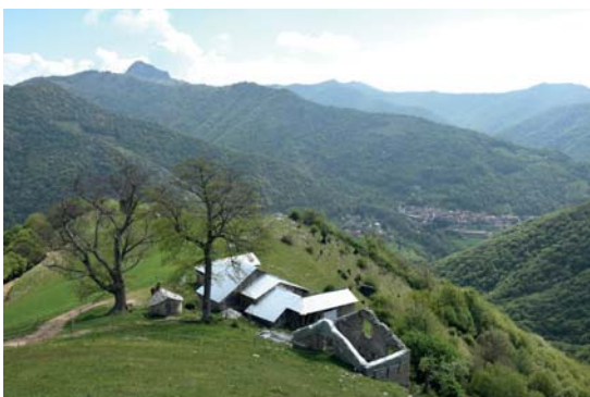
In alto: Una vista di qualche decennio fa sul complesso. Al centro: I vari edifici prima della loro messa in sicurezza. Sotto: Dopo gli interventi nel 2019.
