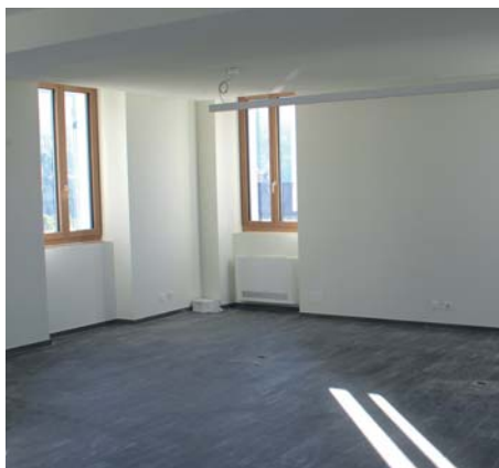
Stabile ex scuole: il tipo di pavimento al PT e al primo piano.
