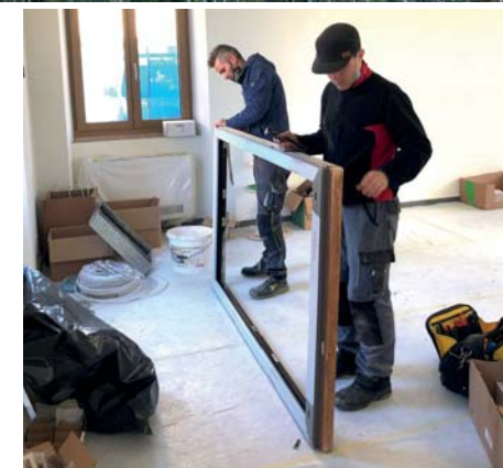
Posa dei serramenti a triplo vetro con finitura del telaio in alu/legno.
