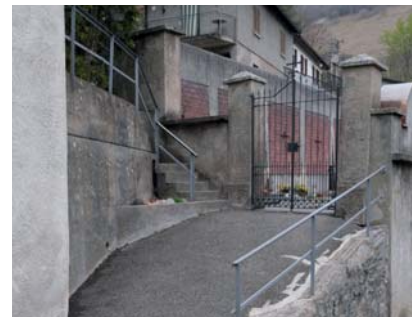
La rampa di accesso del cimitero.
