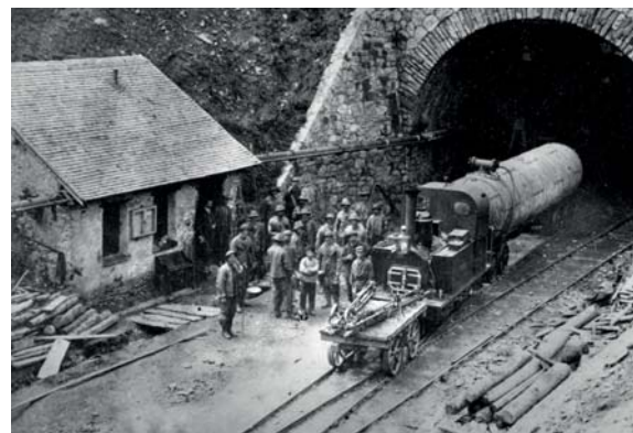
Costruzione della galleria del San Gottardo (1872-1882): potevano essere utilizzate solo locomotive che non venissero alimentate con la combustione per evitare fiamme nel tunnel. Una grande caldaia ad aria compressa forniva l'energia necessaria. (© SBB Historic)
