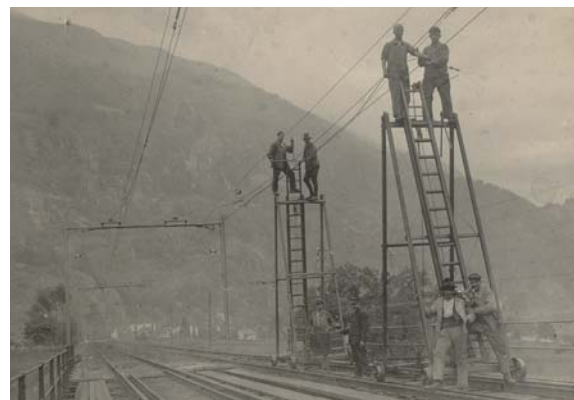
Elettificazione della linea ferroviaria del Gottardo, tratta Faido-Lavorgo, 1923 ca, SBB Kreisdirektion II
