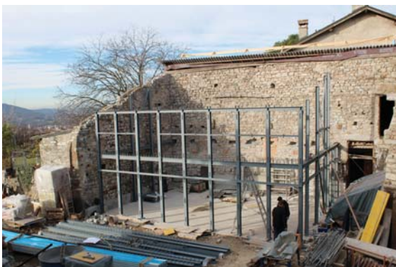
Struttura portante della futura sala multiuso
