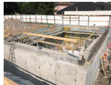
Esecuzione del piano interrato (pareti portanti).
