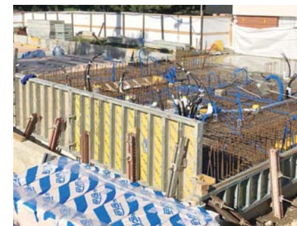
Esecuzione della soletta di copertura del piano interrato.
