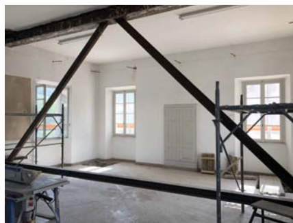
Gli stessi locali durante i lavori di consolidamento delle pareti perimetrali per consentire la demolizione delle solette e dei muri interni non portanti.
