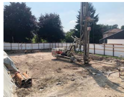
Esecuzione della palificazione.
