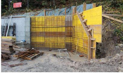
Il nuovo muro in calcestruzzo a sostegno della strada sterrata a monte del posteggio.
