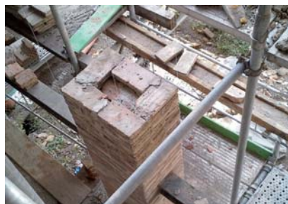
Un particolare di un pilastro dei ballatoi ricostruito con i mattoni di recupero presenti nella Masseria
