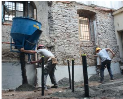
Una fase di lavoro durante la preparazione della platea nella parte adibita allo spazio del preloft.
