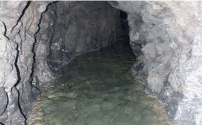
Laghetto di decantazione alla sorgente no.1
